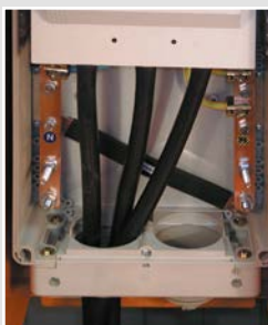
Praxisgerechter und großzügiger Anschlussraum
